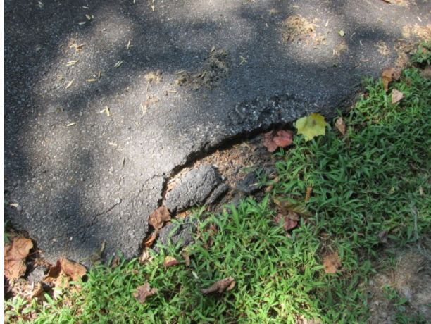
Edge deterioration
