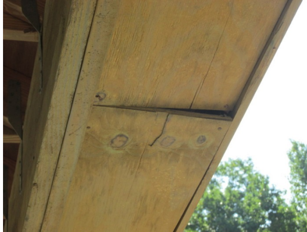
Soffit displacement
